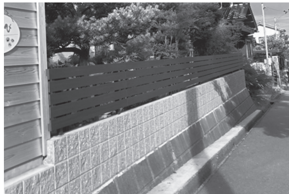
補助制度を利用したブロック塀の改修
