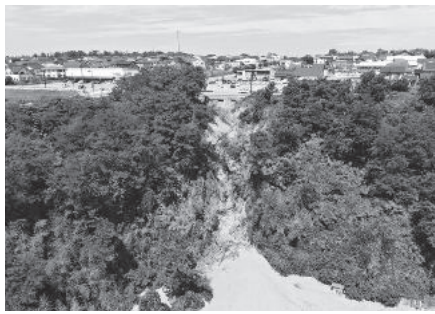
白帆台コンビニ前のがけ崩れ
