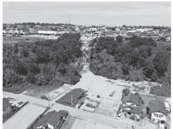
宅地に迫ったがけ崩れ
