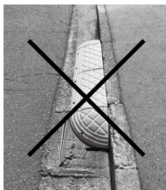
段差解消ブロック
