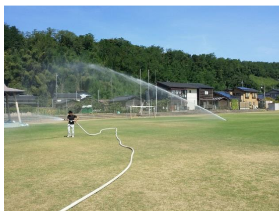
【西荒屋小学校散水設備】
