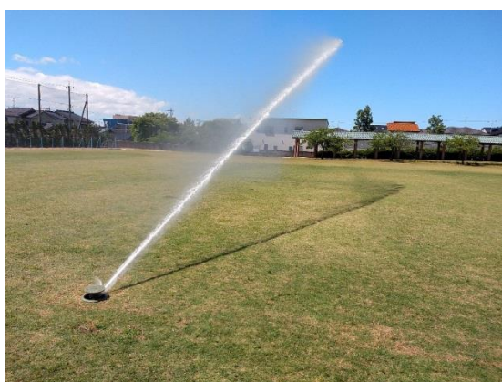
【清湖小学校散水設備】
