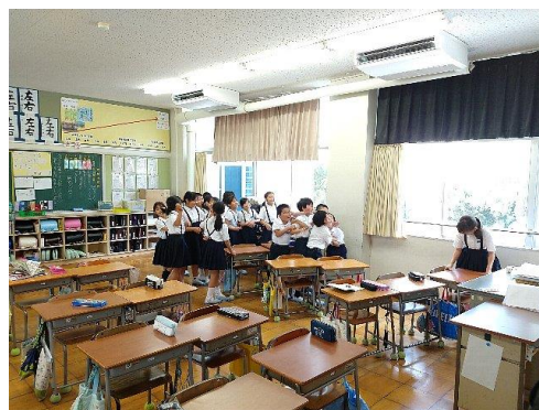
【小学校に空調設備を整備】
