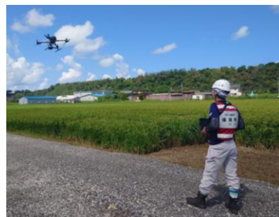
ドローンを活用した航空撮影測量を実施しました
