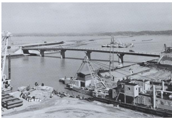
河北潟放水路建設工事の様子
