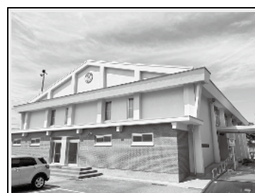
鶴ヶ丘小学校体育館
