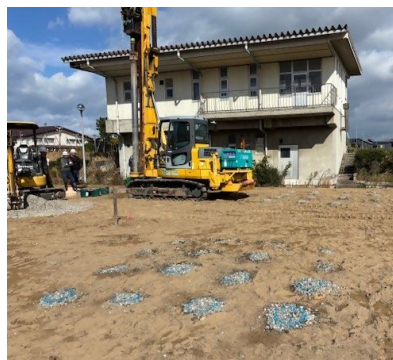
地盤改良工法実験の様子
