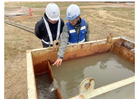
地下水の排出状況を確認
