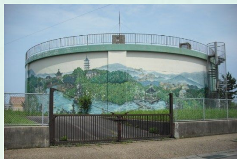
大根布配水池
