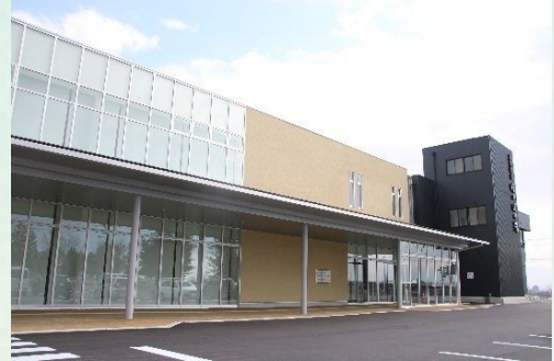
内灘町防災コミュニティセンター（ほのぼの湯）
