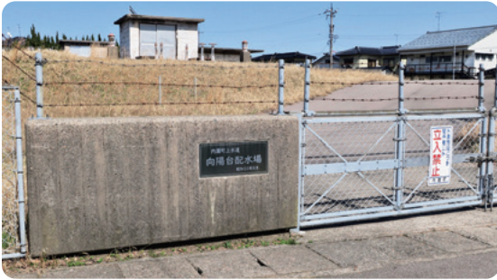
向陽台配水場
