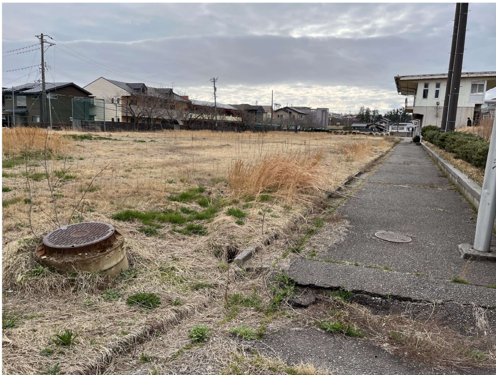
図 地盤改良工法エリアB 状況写真
