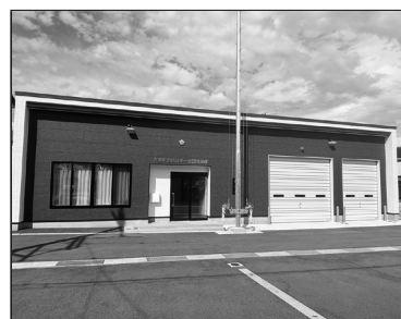
消防団第一分団格納庫 建設事業
