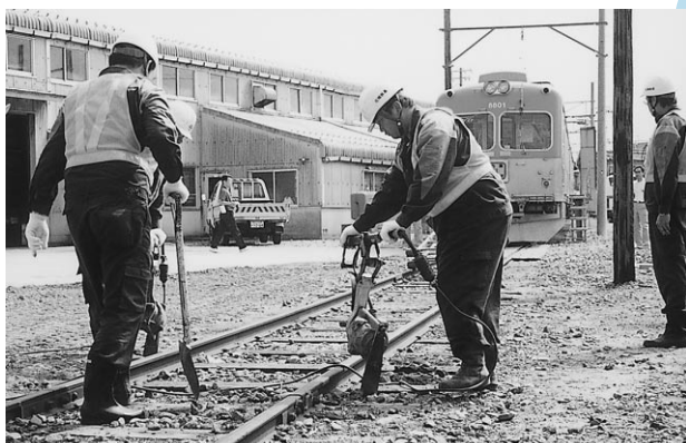
線路災害応急復旧訓練
