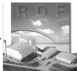
石川北部RDFセンター (志賀町)
