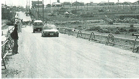
アーバンリゾート計画地への配水管布設事業
