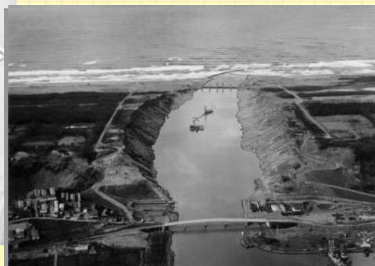
●内灘町を南北に分けた放水路工事の全景
