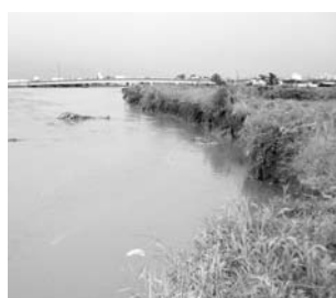
大きく削り取られた大野川沿いの堤防
