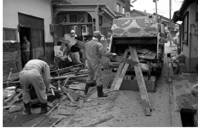
金沢市内での作業の様子。1階床下に溜まった泥を除去するため、床板を全て剥がす
