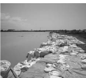
決壊寸前だった堤防を大型土のうでの補強
