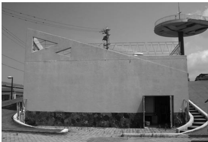
内灘町総合公園展望台下 貯水槽
