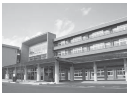
内灘中学校新校舎
