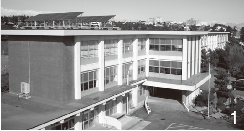
鶴ヶ丘小学校の屋上に設置された太陽光パネル
