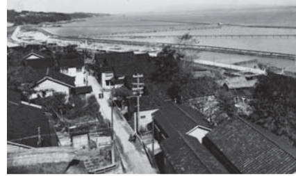
▲旧役場屋上から撮影した、大根布地区 埋立事業の様子(昭和34年)
