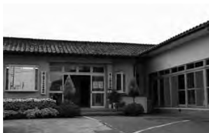
公民館の耐震補強工事
