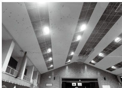
内灘中学校体育館(天井)
