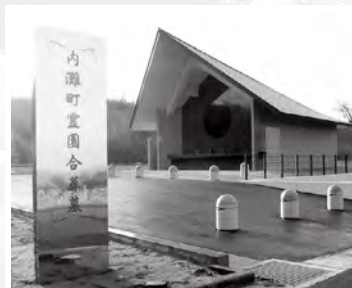
内灘町霊園内に建設された合葬墓
