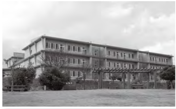
▲完成間近の白帆台小学校
