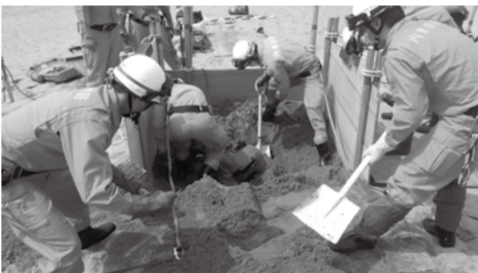
囲い応急土留め救出訓練の様子
