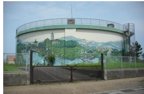
大根布配水池
