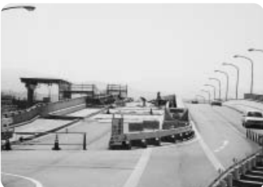
全線開通に向け工事する内灘湊大橋
