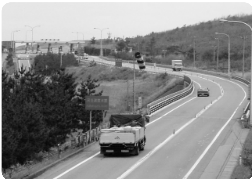
能登有料道路の内灘料金所付近
