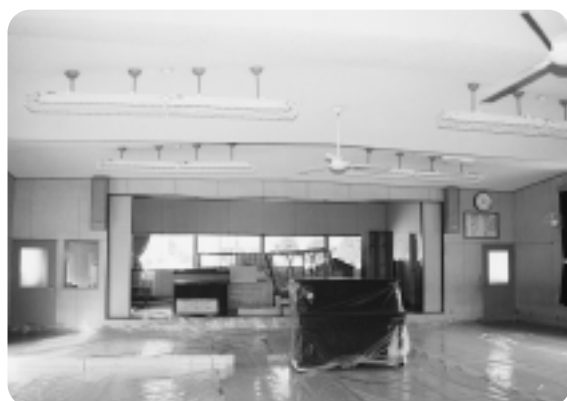
天井の改修工事（鶴ヶ丘保育所）
