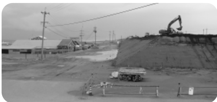
有料道路直線化の盛土工事
