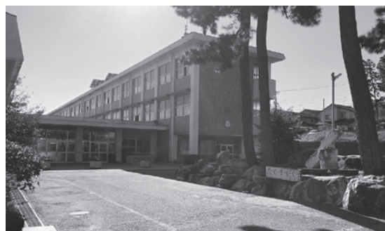
大規模改修が予定されている大根布小学校
