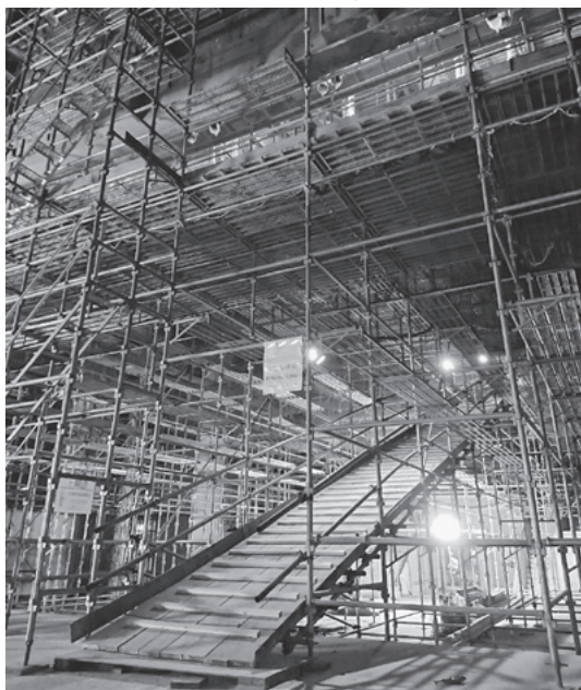
改修工事中の文化会館大ホール
