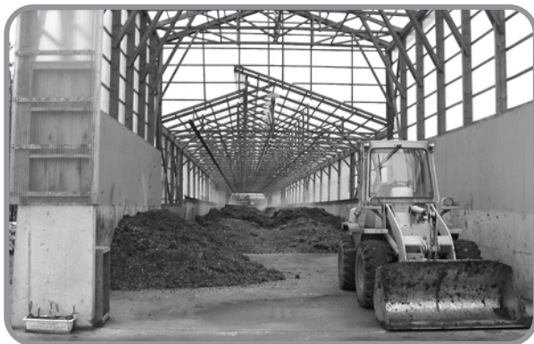
河北潟の堤防付近にある堆肥舎
