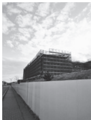
建設がすすむ白帆台小学校
