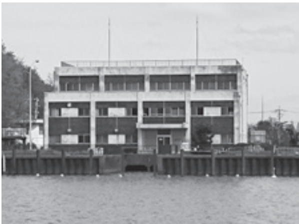
計画の認識を示せ（内灘排水機場）
