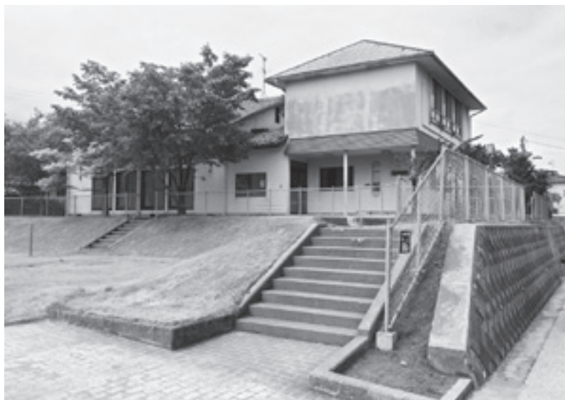
災害に備え施設整備を急げ（向栗崎 5 丁目東集会所）
