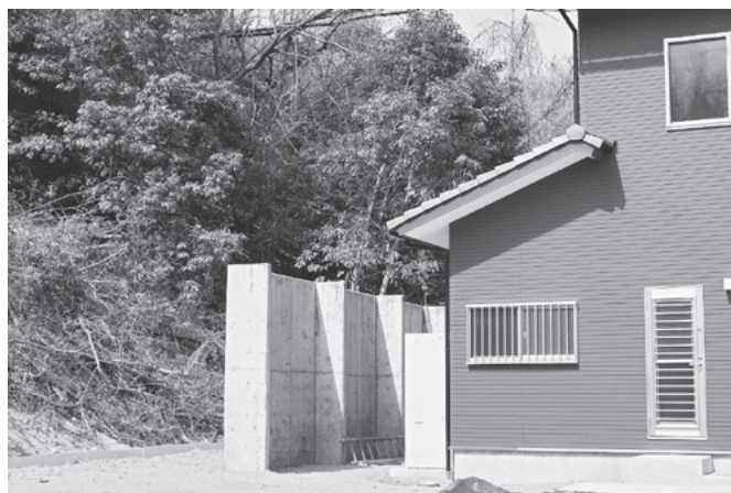
土砂災害対策のため設置された擁壁（西荒屋）
