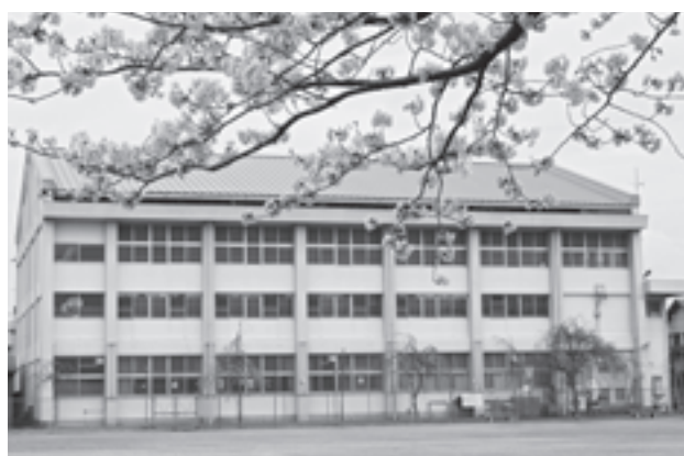
耐震補修される向栗崎体育館
