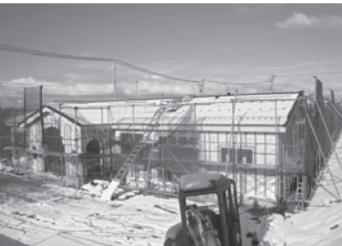
建設の進む千鳥台幼稚園（仮称）
