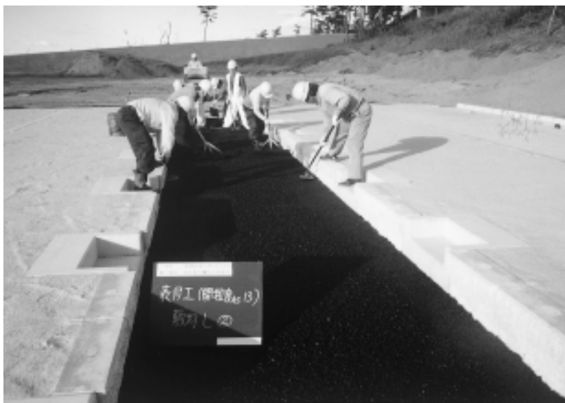
平成20年度の霊園拡張工事
