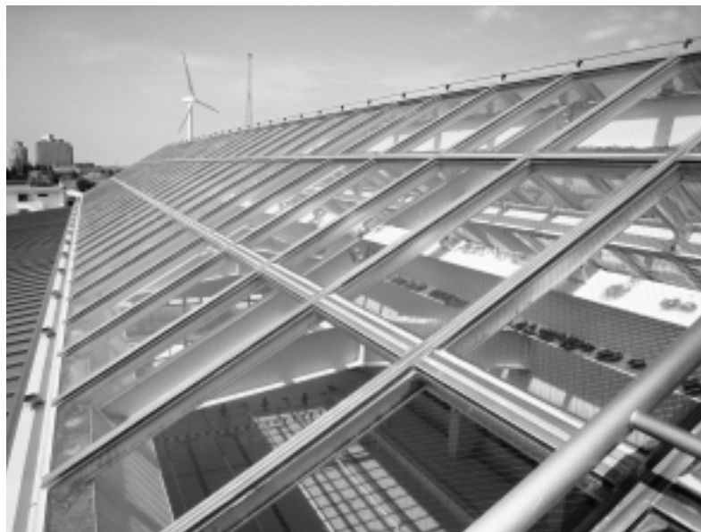
温水プール屋上部
