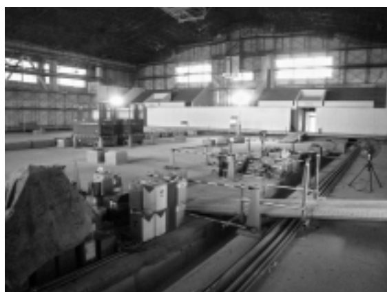
改修が進む総合体育館
