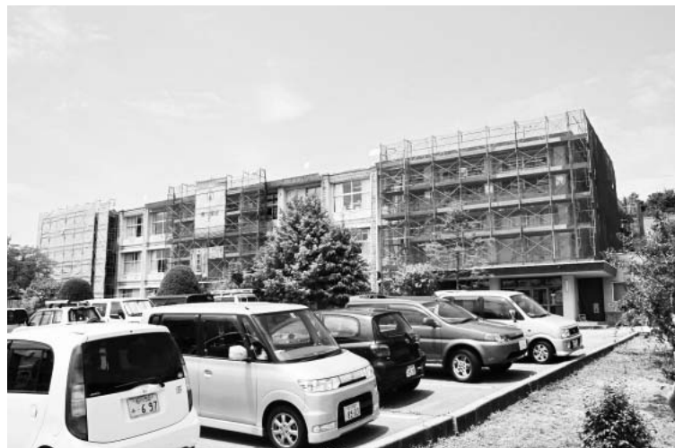
工事が進む西荒屋小学校
