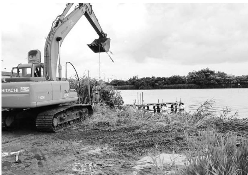
撤去される棧橋
