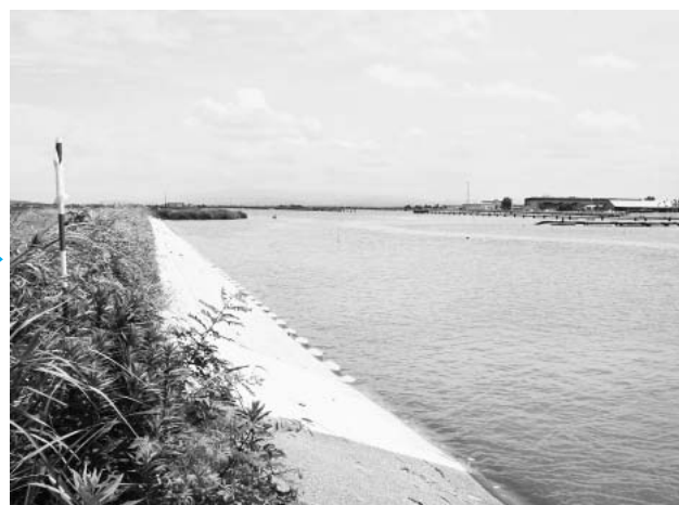
復旧を終えた大野川堤防
