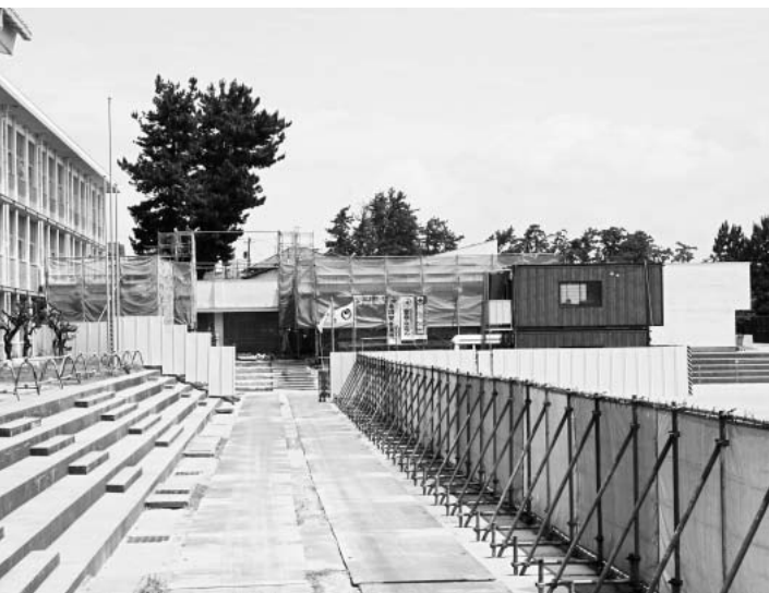
大根布小学校の増築工事
