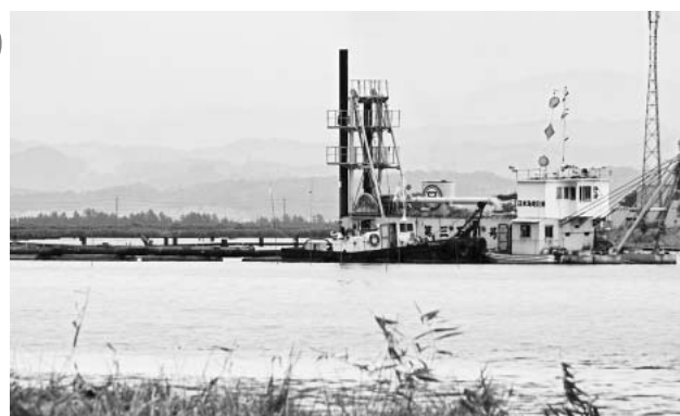
大野川の堆積土砂の浚渫工事
