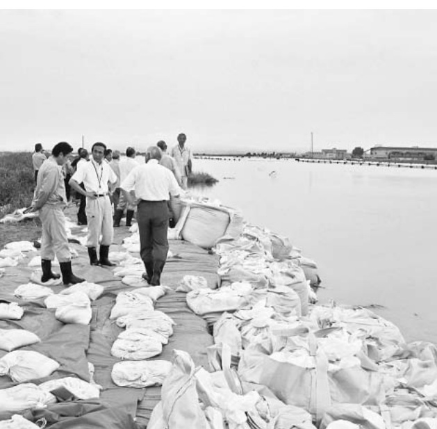
7月28日の集中豪雨による増水で損壊した大野川堤防
