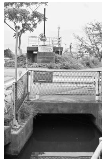
大野川の堤防に設置されている水門
