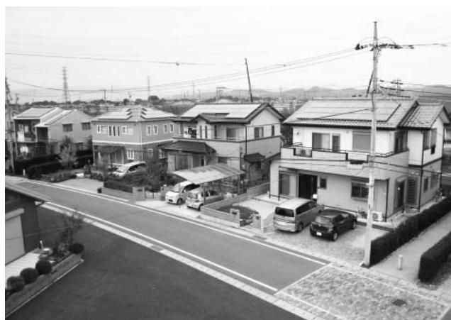
553戸の住宅に太陽光発電システムが設置されている群馬県太田市の「パルタウン城西の杜」
