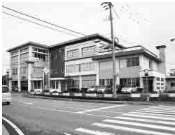
築35年が経過した福祉センター
