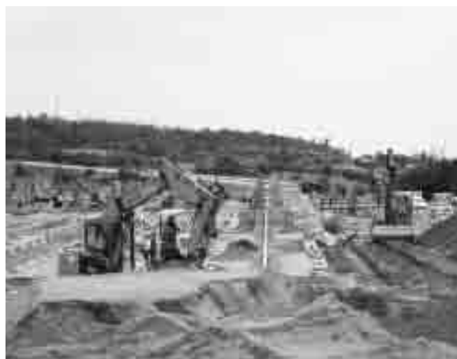
霊園の第9期造成工事中
