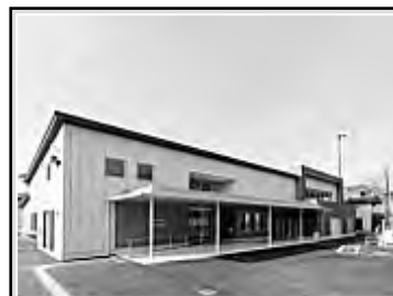
内灘町地域防災センター (大根布地区)
