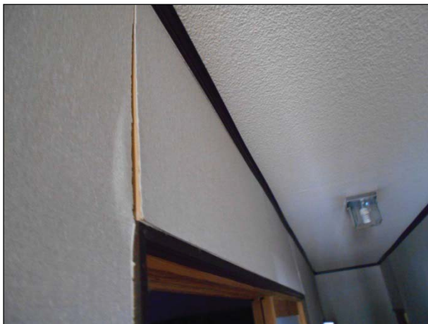
【内部仕上】 内壁合板に剥離、浮きが見られる。
