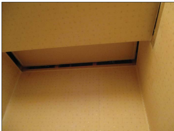
【天井】 天井板の浮きが生じている。
