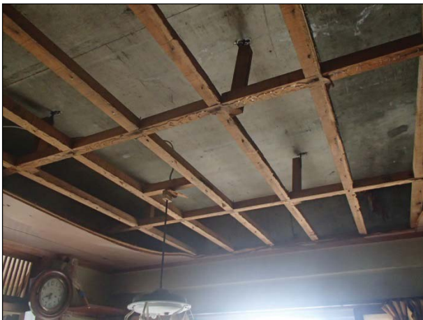
【天井】 天井板が脱落している。
