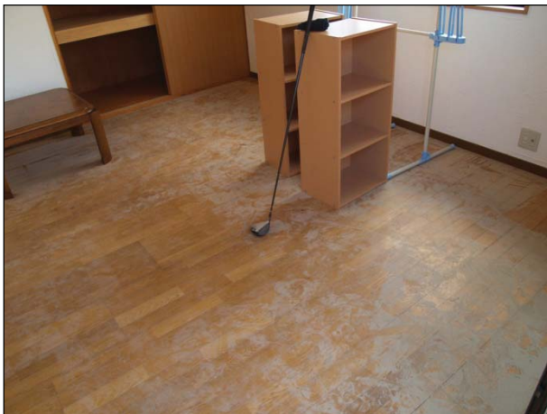
浸水により床材の汚損が見られる。
