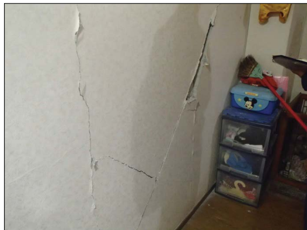
【内部仕上】 ボードの釘の浮き上がりが見られ、脱落が生じている。
