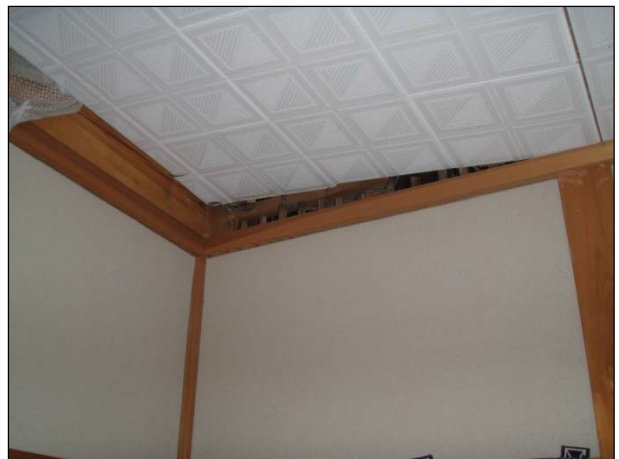
【天井】 天井板の浮きが生じている。
