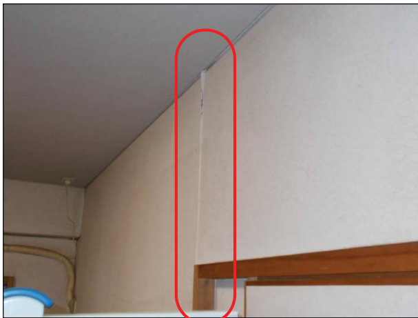
【内部仕上】 内壁合板にずれが生じている。
