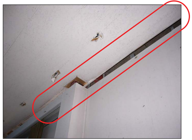
【天井】 天井板のずれが見られる。
