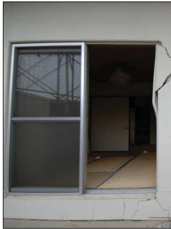
【アルミサッシ】 可動部が全損しており、枠の一部に変形が見られる。
