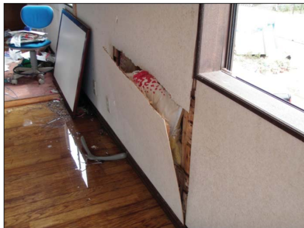
【内部仕上】 内壁合板に剥離、脱落が見られる。
