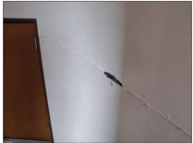
【内部仕上】 クロスが破れている。
