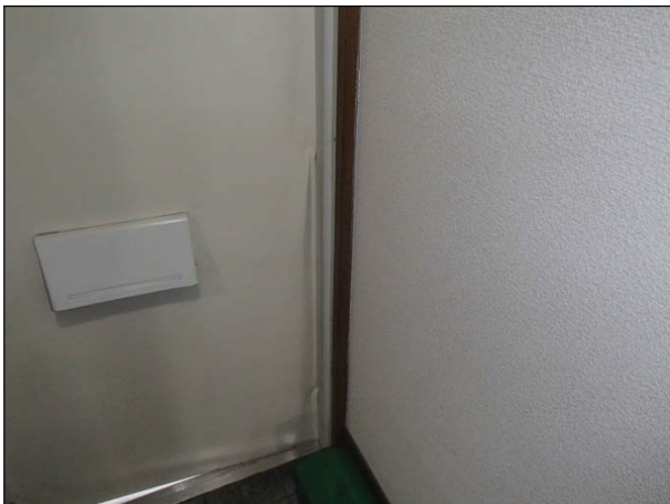
【ドア】 蝶番に変形が見られ、取り付け部がはずれている。
