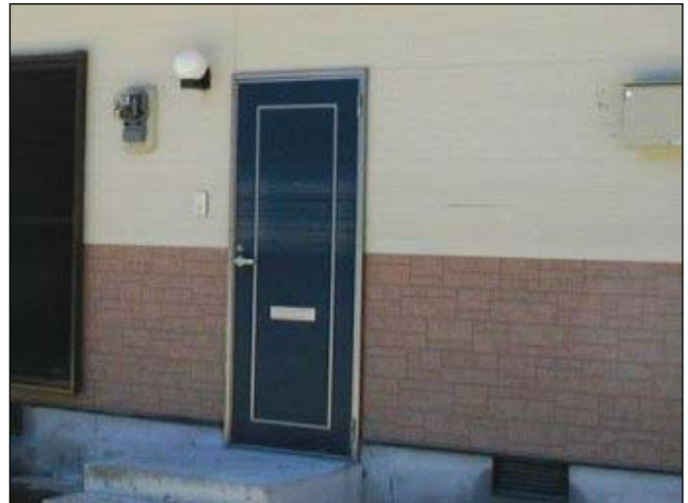
【ドア】 浸水によるドアの破損(表面、格子・縁の洗浄によって、再使用が可能な程度)
