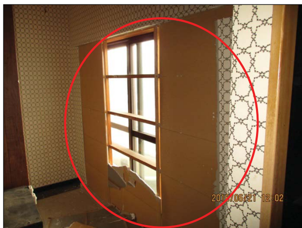
【内部仕上】 全ての仕上材が脱落している。
