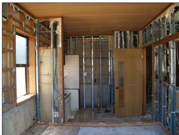
【内部仕上】 浸水により下地材、パネルの吸水、膨張、不陸が見られる。
