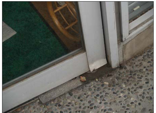
【ドア】 (変形が見られ、取り付け部がはずれている。)
