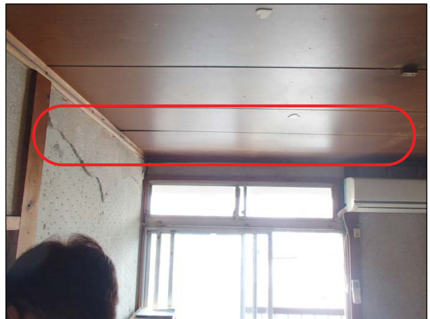
【天井】 天井板に隙間が生じている。
