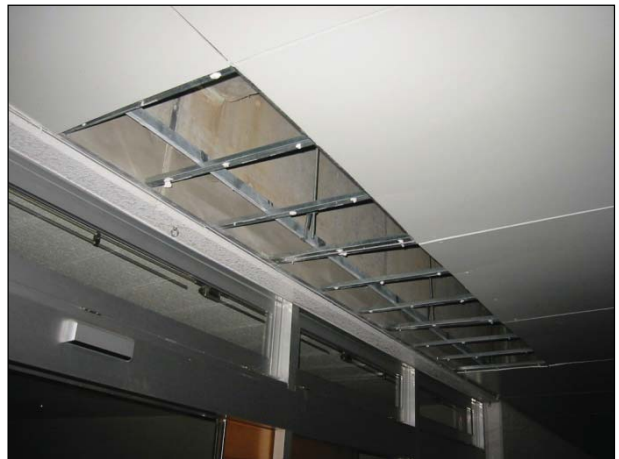
【天井】 天井板が脱落している。
