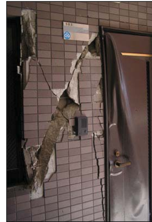
【雑壁】 全体にひび割れ(幅約1mm~5mm)やはがれが生じている。
