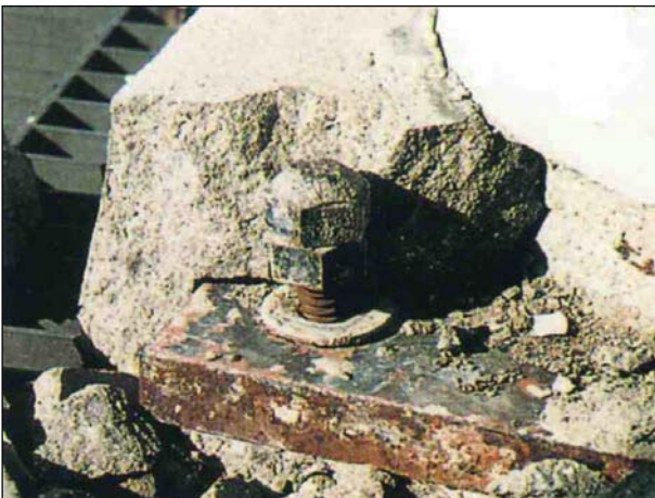
アンカーボルトの伸びが見られる。
