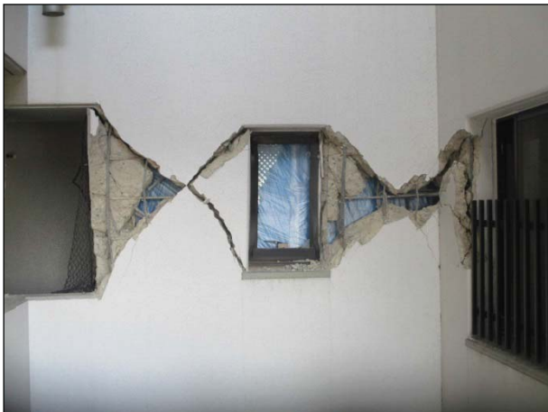
【雑壁】 全体が変形し、仕上の大部分が剥落している。
