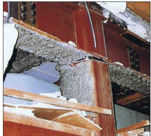
接合部の破断が見られる。
