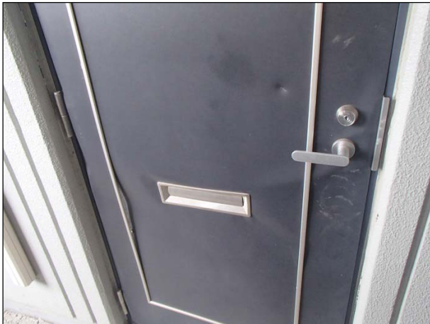
【ドア】 変形はしていないものの、表面の傷が著しい。
