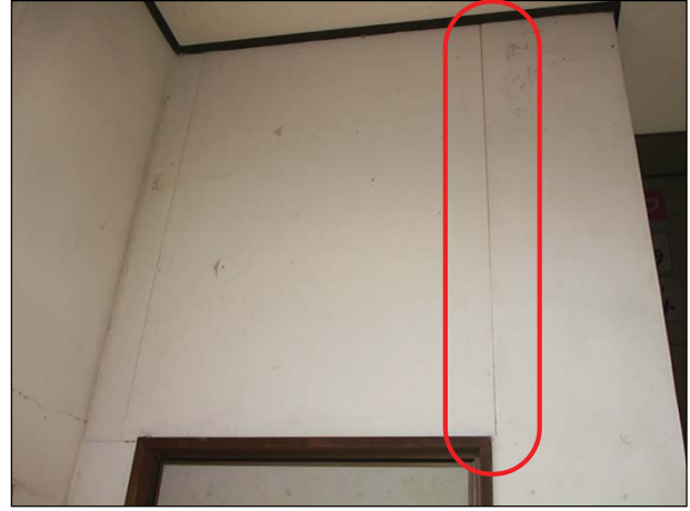
【内部仕上】 ボードの目地部にわずかなずれが生じている。
