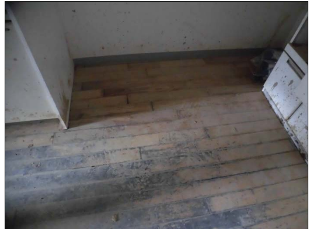
浸水により床材の汚損が見られる。
