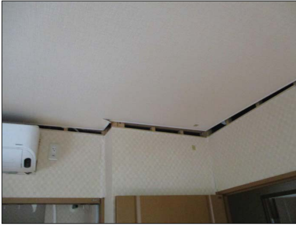
【天井】 天井板のずれが見られる。
