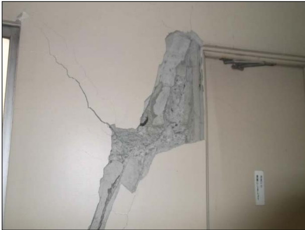
【雑壁】 全体にひび割れ(幅約1mm~5mm)やはがれが生じている。
