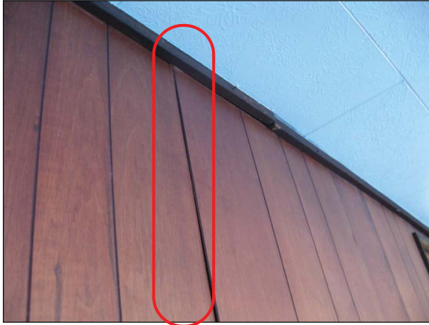
【内部仕上】 内壁合板にわずかなずれが生じている。
