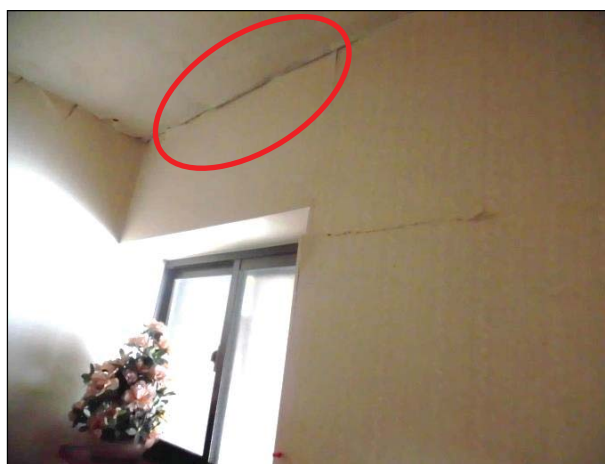
天井板に隙間が生じている。
