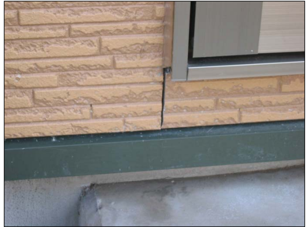
【ボード】 目地にわずかなずれが生じている。
