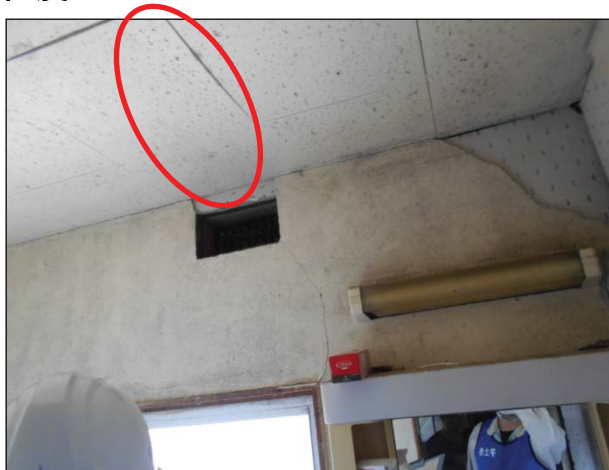
天井板に隙間が生じている。
