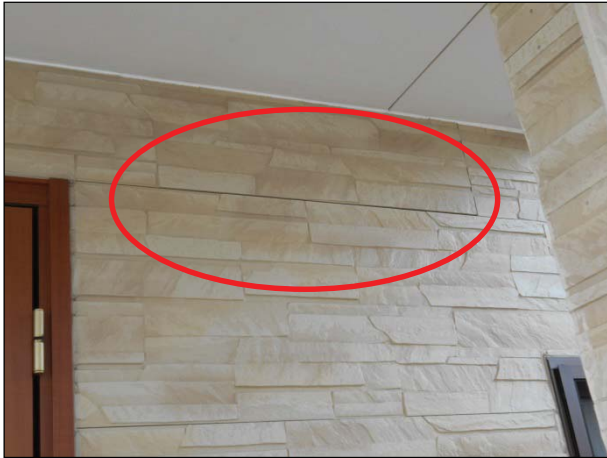
【ボード】 目地にわずかなずれが生じている。
