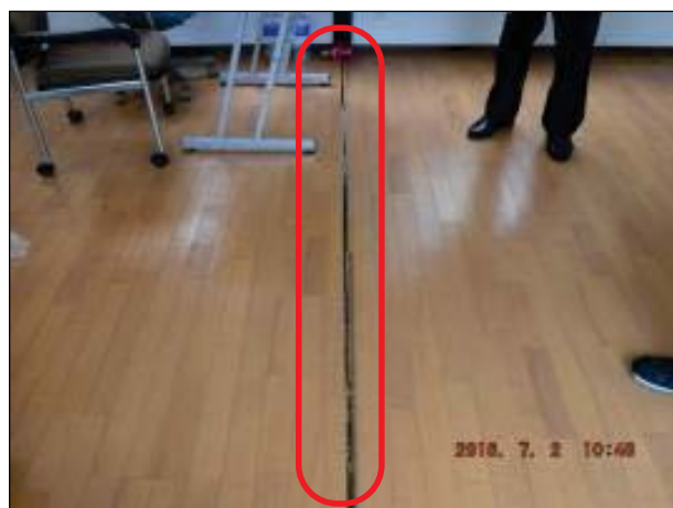
床板の継目に隙間が生じている。
