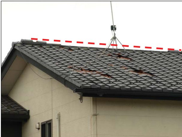
棟瓦が全面的にずれ、破損あるいは落下している。
