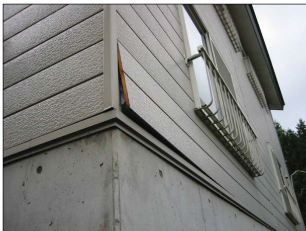
【ボード】 目地部に著しいずれ、面材釘打部の部分的な浮き上がり、ボード隅角部の破損が生じている。
