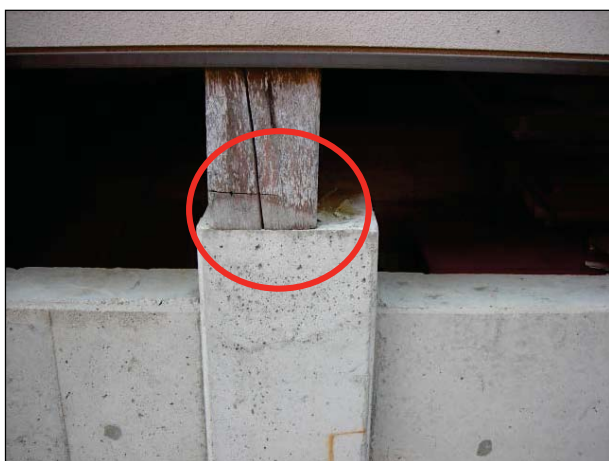
束が束石よりわずかにずれている。
