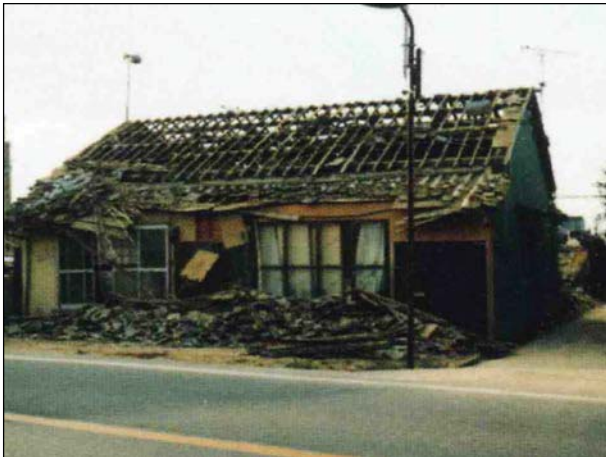
小屋組の損傷が著しく、葺材の大部分が損傷を受けている。
