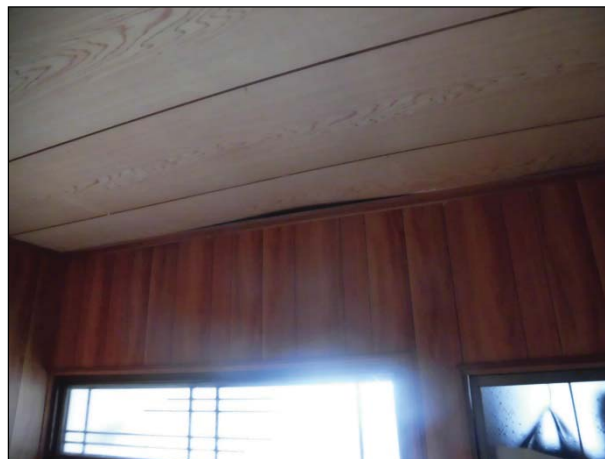
天井板の浮きが生じている。
