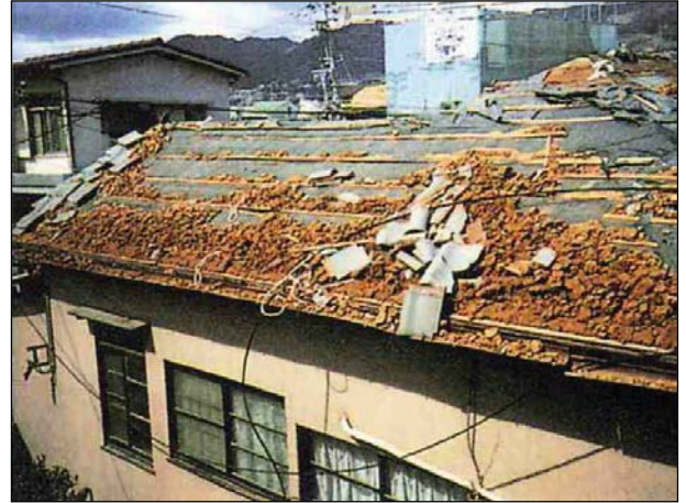
瓦がほぼ全面的にずれ、破損又は落下している。
