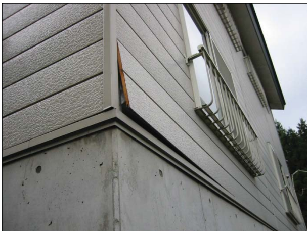
【ボード】 目地に著しいずれ、面材釘打部の部分的な浮き上がり、ボード隅角部の破損が生じている。
