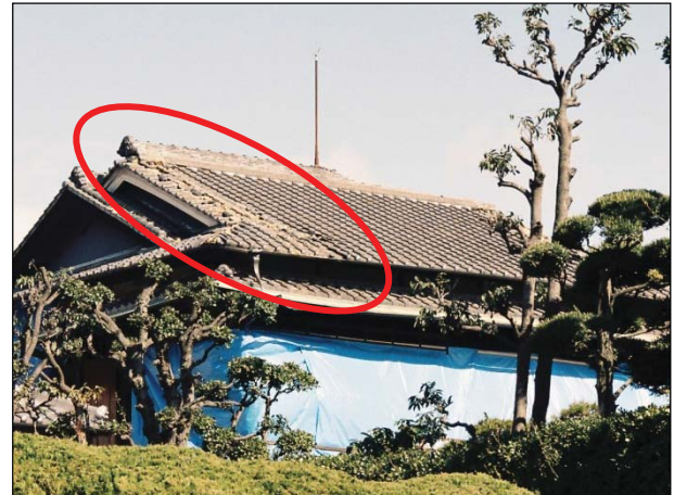
棟瓦以外の瓦もずれが著しい。
