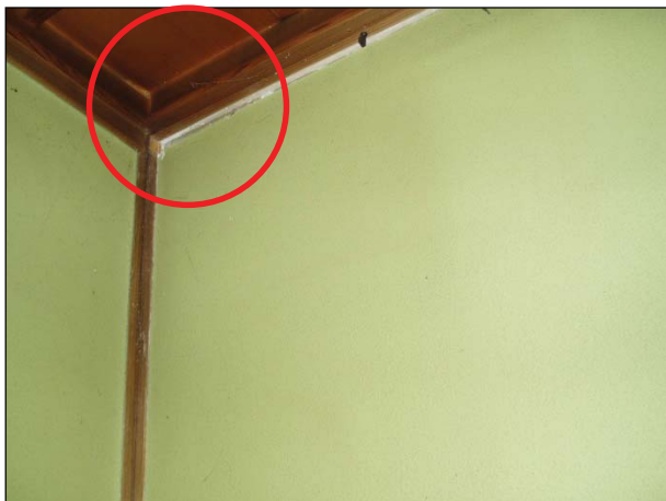
内壁周辺部に隙間が生じている。
