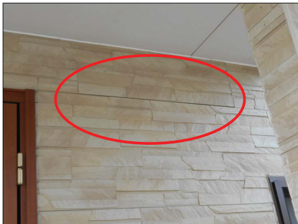
【ボード】 目地部にわずかなずれが生じている。
