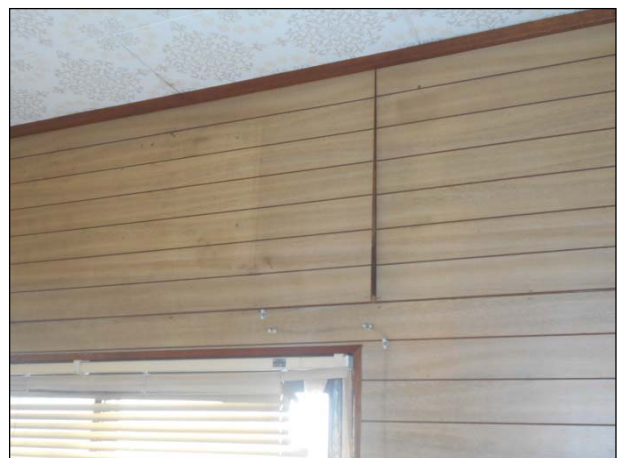
内壁合板にずれが生じている。
