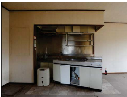
(台所の流し台：移動し、損傷は大きいが再利用は可能。(2%))
