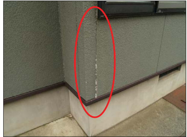
【仕上面】 ボードの目地部にわずかなずれが生じている。
