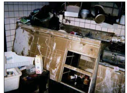
(台所の流し台：転倒し、配管が切れ、再使用は不可能。(3%))
