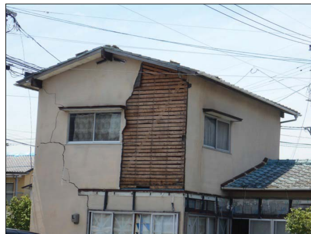
【モルタル塗り仕上等】 仕上材が脱落している。
