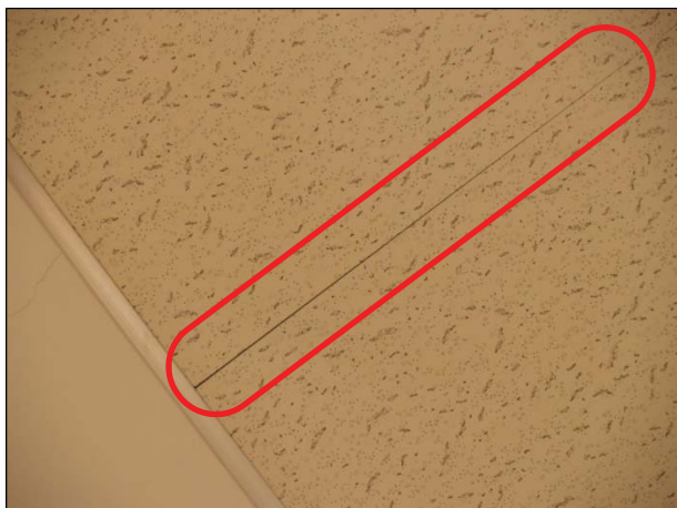
天井板にわずかな隙間が生じている。
