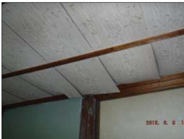
天井面に歪みが見られる。 天井板のずれ、一部脱落が見られる。
