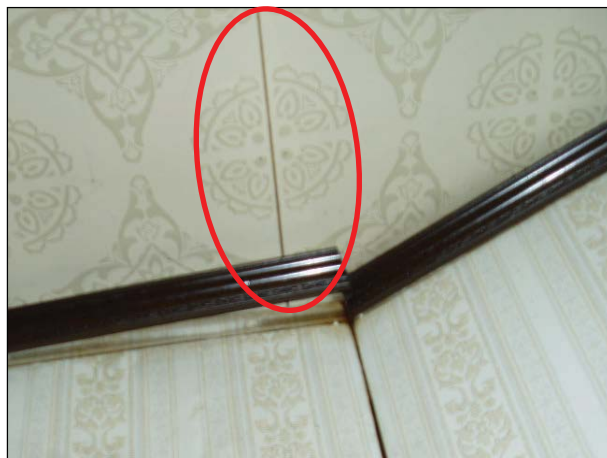
天井板にわずかな隙間が生じている。
