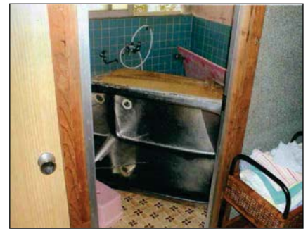
(浴槽：転倒し、配管が切れ再使用が不可能。(3%))
