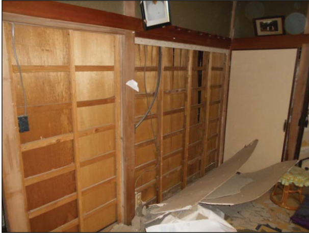
内壁合板に剥離、脱落が見られる。
