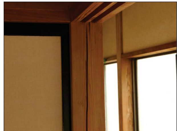
【在来工法】 柱、梁に割れが見られる。
