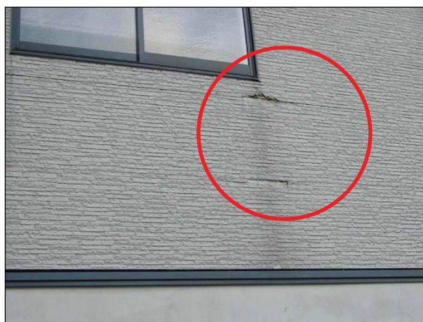
【ボード】 仕上面の目地部にひび割れやずれが生じている。
