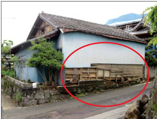
仕上材が脱落しており、下地材に破損が生じている。
