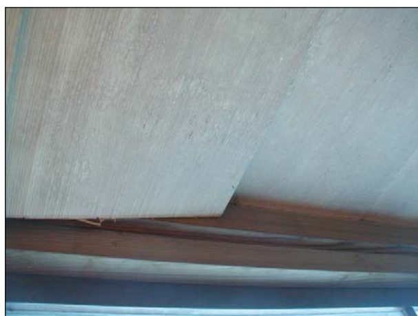
天井板の浮きが生じている。
