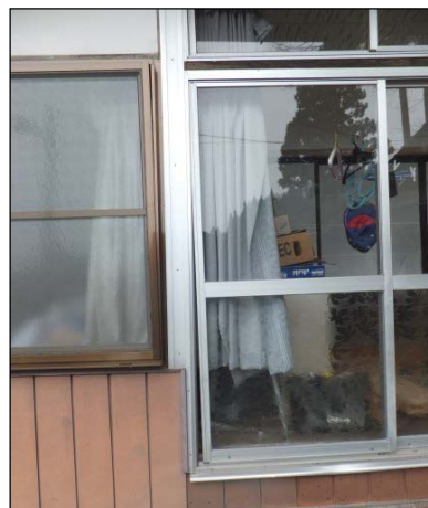
【アルミサッシ】 可動部、鍵にわずかな変形が生じ、開閉が困難になっている。
