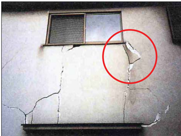
【仕上面】 塗壁の各所で仕上の脱落が生じている。
