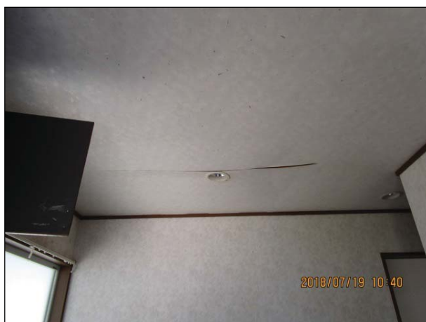
天井板に隙間が生じている。
