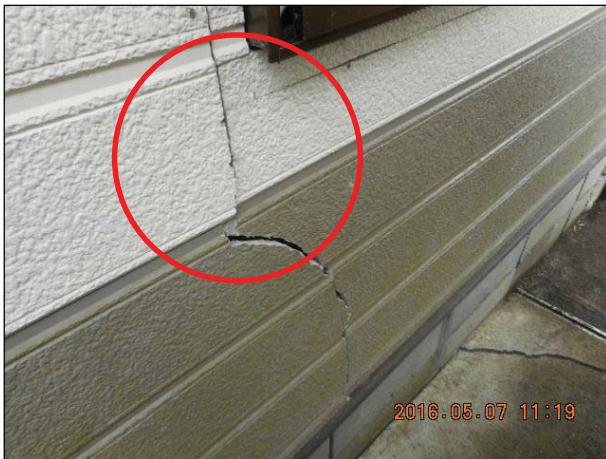
【ボード】 仕上面の目地にひび割れやずれが生じている。
