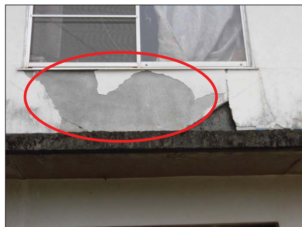
【モルタル塗り仕上等】 仕上の剥離が生じている。
