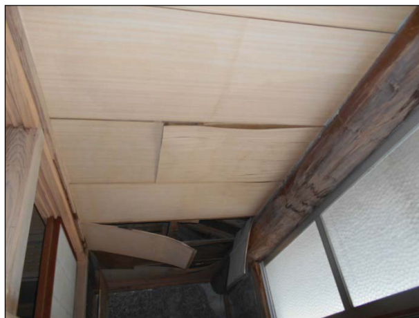
天井面に歪みが見られる。 天井板のずれ、一部脱落が見られる。
