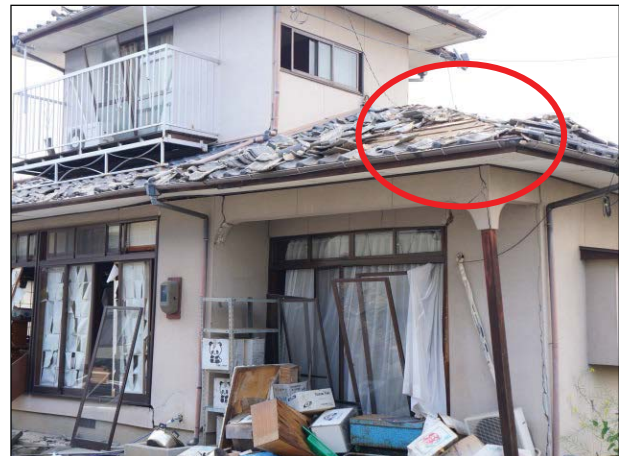
棟瓦以外の瓦もずれが著しい。
