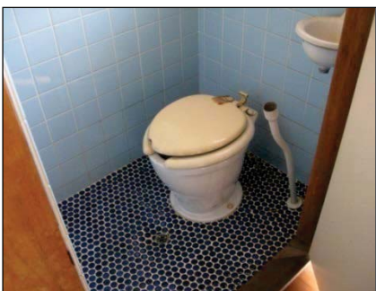
(便器、手洗い：配管が外れている。)
