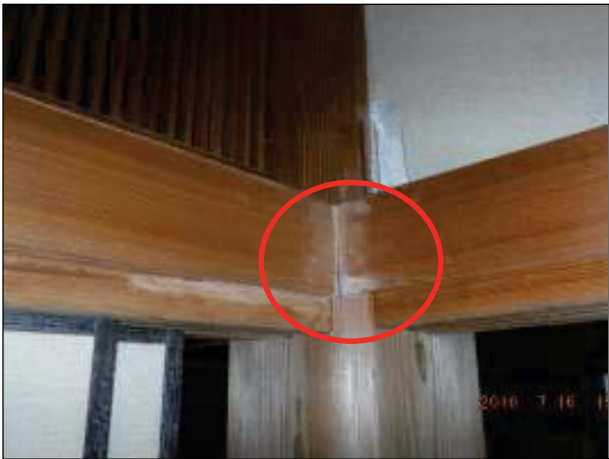
【在来工法】 一部の柱と梁の仕口にめり込み等の損傷が見られる。
