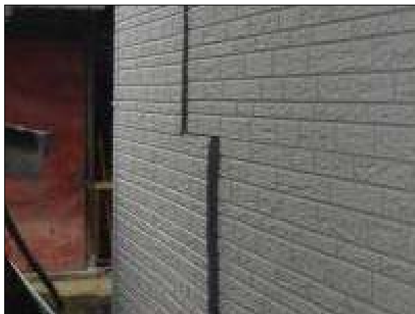
【ボード】 目地部に著しいずれ、面材釘打部の部分的な浮き上がり、ボード隅角部の破損が生じている。
