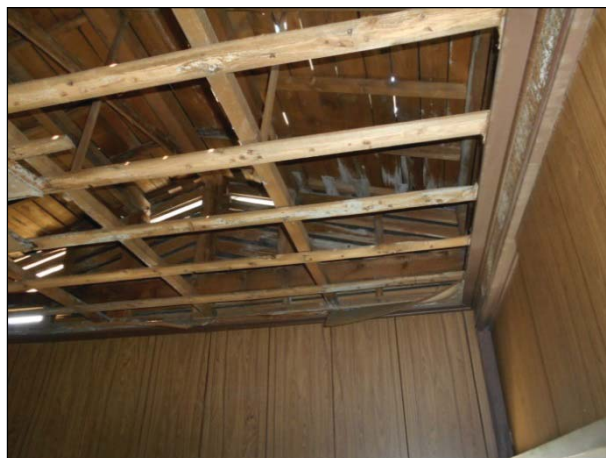
天井板が脱落している。
