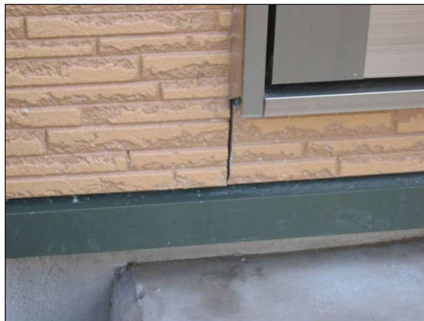
【ボード】 目地部にわずかなずれが生じている。
