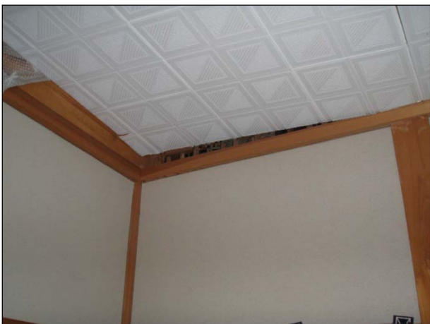
天井板の浮きが生じている。
