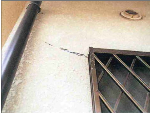
【仕上面】 塗壁の開口部隅角部廻りにわずかなずれが生じている。
