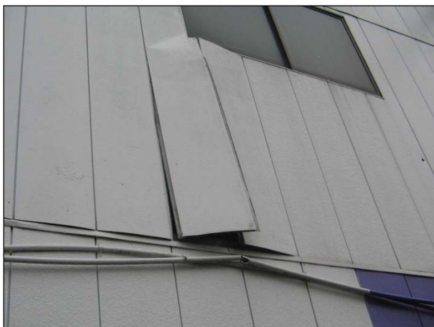
【仕上面】 ボード仕上の壁ではボード間に著しいずれが生じている。
