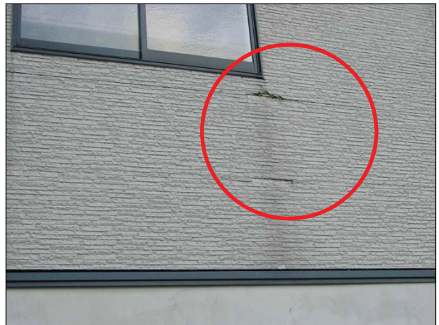
【ボード】 仕上面の目地にひび割れやずれが生じている。
