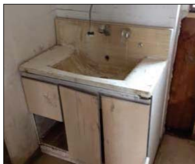
(洗面：汚損し、配管が詰まっている。)
