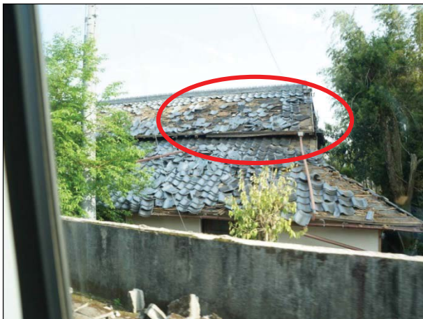
棟瓦以外の瓦もずれが著しい。
