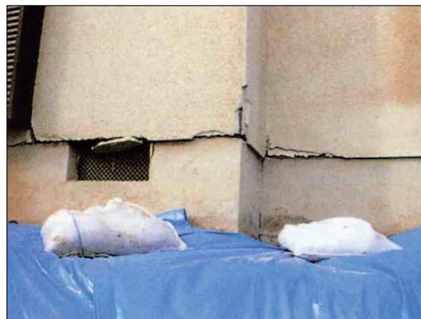
土台が基礎からわずかにずれている。
