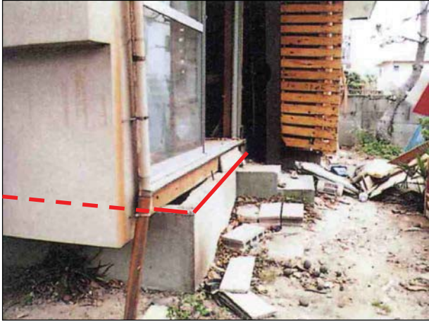
土台が基礎から著しくずれている。
