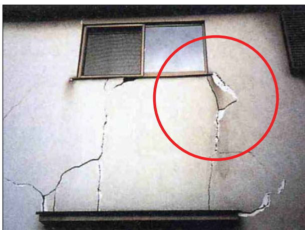
【モルタル塗り仕上等】 仕上の剥離が生じている。
