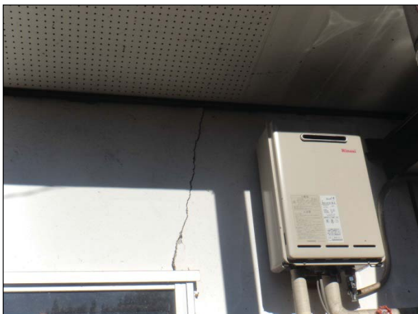
【モルタル塗り仕上等】 開口隅角部廻りにわずかなひび割れが生じている。
