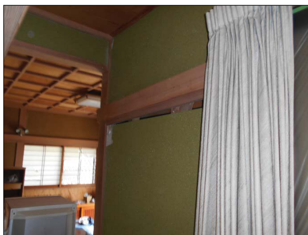
ボードの目地部に著しいずれ、釘打部の部分的な浮き上がり、隅角部の破損が生じている。
