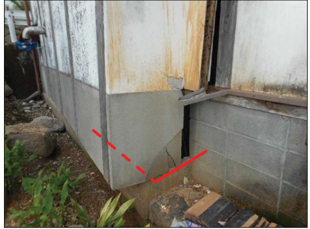
土台が基礎から著しくずれている。
