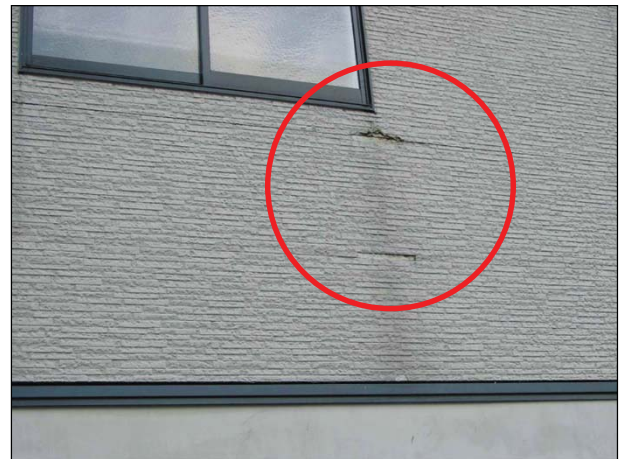
【仕上面】 ボード仕上の壁では一部のボードの仕上面の目地部にひび割れやずれが生じている。
