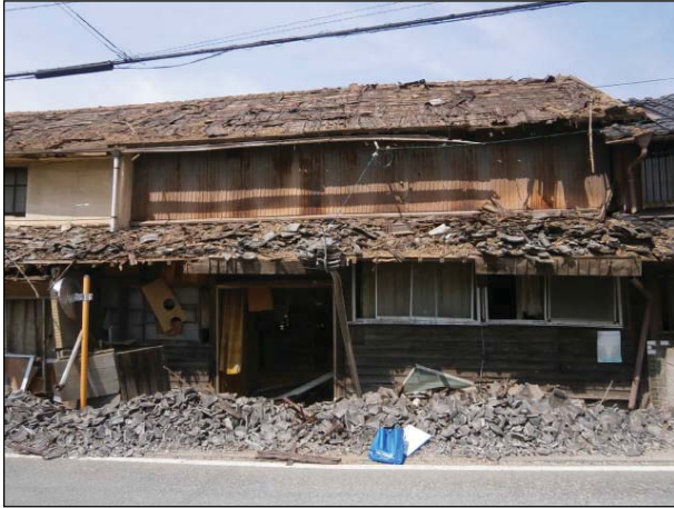
瓦がほぼ全面的にずれ、破損又は落下している。
