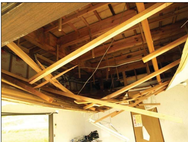
天井板が脱落している。
