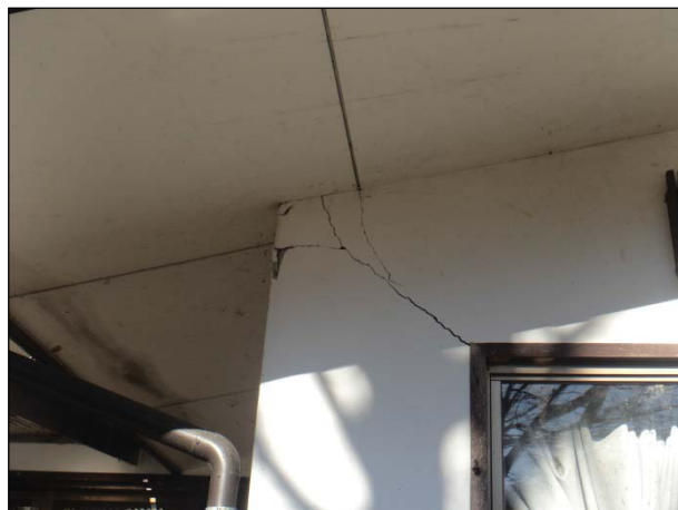
【モルタル塗り仕上等】 開口隅角部廻りにわずかなひび割れが生じている。
