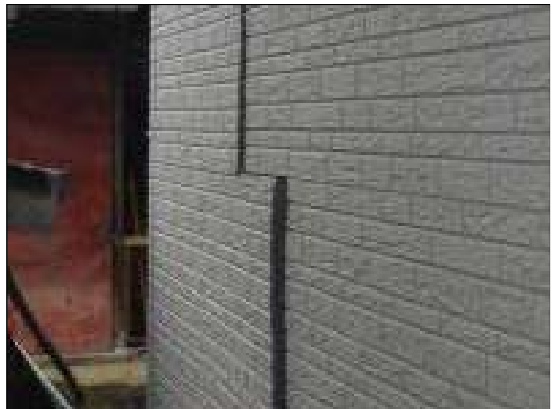
【ボード】 目地に著しいずれ、面材釘打部の部分的な浮き上がり、ボード隅角部の破損が生じている。
