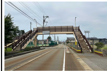
①内灘中学校前歩道橋
