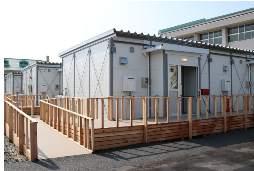
町内4か所で応急仮設住宅が完成、入居を開始しました
