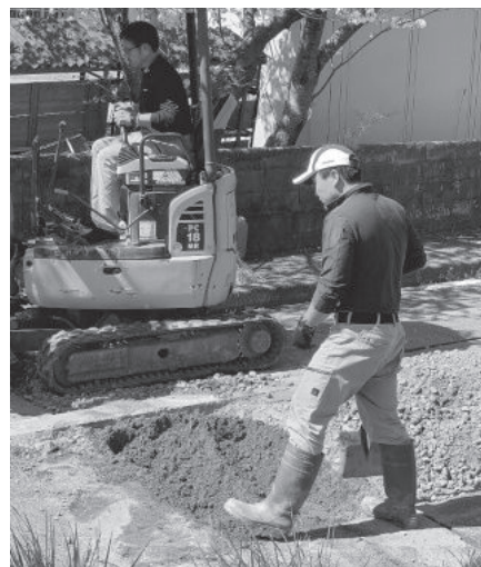
水道復旧作業中
