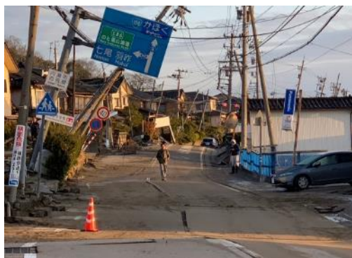
【道路の被害状況】
