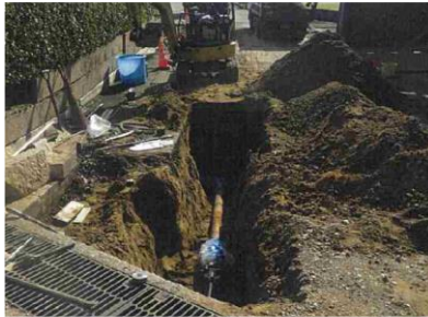
水道管の復旧作業
